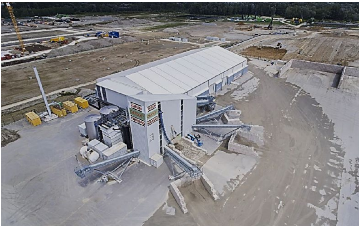
Obrázok 2.3- Celkový pohľad na pracie zariadenie (predná strana), zariadenie na spracovanie kalu (na ľavej strane) a príjmaciu halu (vzadu). Autor fotografií: Benjamin Faigle – Züblin Umwelttechnik GmbH
